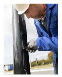
3. Utilisez le boulon à œil fourni et vissez-le dans le trou débouchant taraudé M6 situé sur la partie extérieure de la cale de sécurité. Placez l'autre main en hauteur sur la partie supérieure du mât et démontez la cale de sécurité. Continuez ensuite à soutenir d'une main la partie supérieure du mât.
