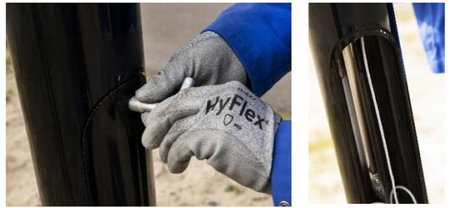
2. Alle vier M12-Bolzen (10 mm Innensechskant) im Innern des Mastes mit einem Ratschenschlüssel, Inbusschlüssel oder ähnlichem Werkzeug (H12 Innensechskant) lösen (drei bei einem Mast mit Durchmesser 145 mm).
