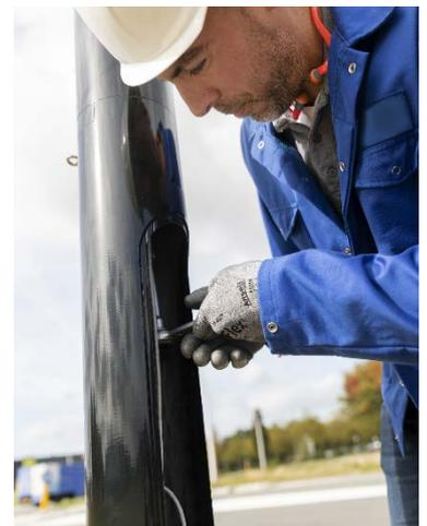
3. Den mitgelieferten Augbolzen in das M6-Gewinde M6 an der Außenseite des Sicherheitskeils schrauben. Die andere Hand hoch oben am oberen Teil des Mastes ansetzen und den Sicherheitskeil demontieren. Danach den oberen Teil des Mastes mit einer Hand weiter abstützen.
